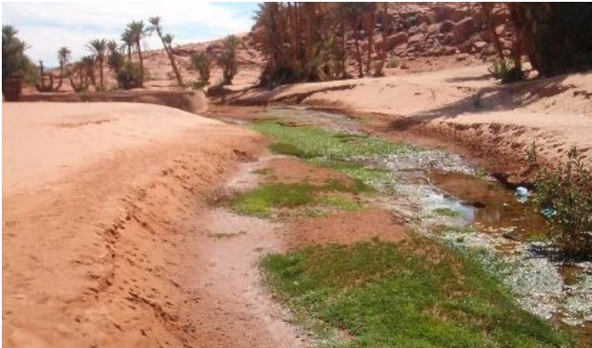
a) Tiout Dam silted up in 2017 (Remini, 2022)
