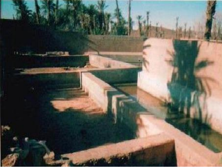
Figure 6 : Bassin d'accumulation d'eau (Madjen) de la foggara (janvier, 2008)
