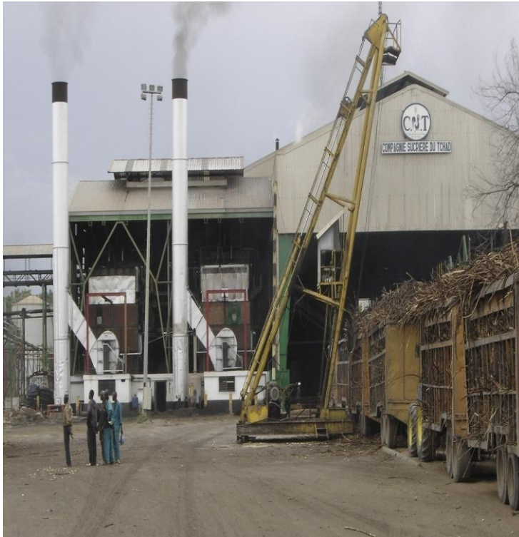
Photo 2 : Complexe Agro-industriel (département usine) de Banda/Sarh
