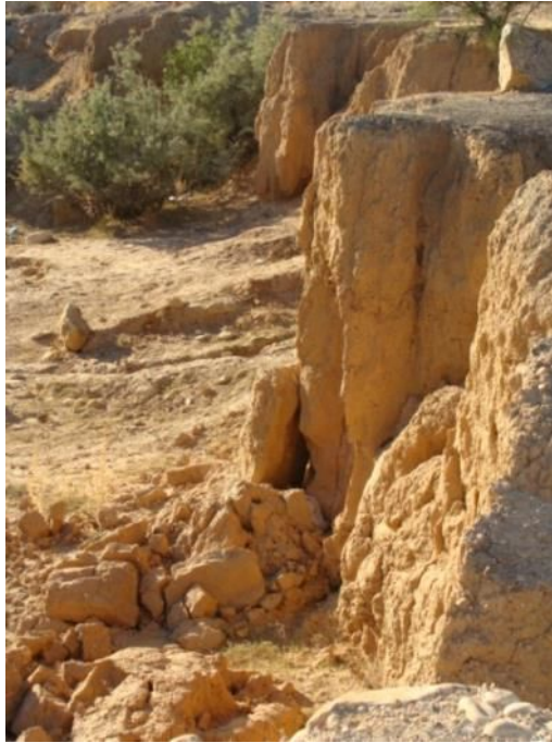
Figure 6 : Un foyer de sapement des berges dans l'oued El Hammam (cliché. Remini, 2011)
