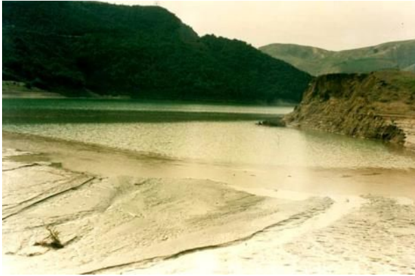
Figure 17 : Envasement du barrage d'Ighil Emda (Cliché Ouaret, 2004)
