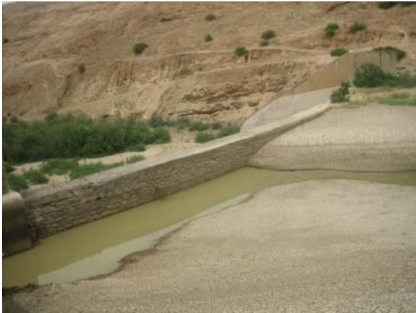
Figure 18 : Comblement total d'un petit barrage sur l'oued Chellif (cliché, Hamoudi, 2004)
