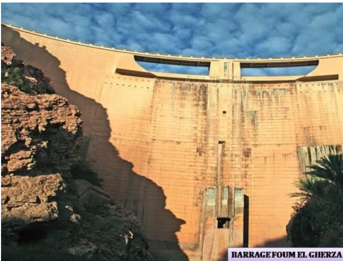
Figure 27 : Vanne de fond du barrage de Foug El Gherza (Cliché. ANBT Biskra, 2006)
