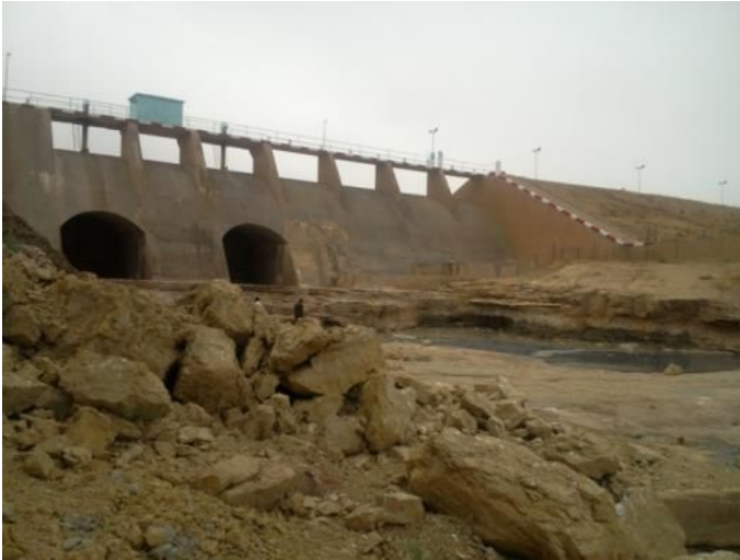
Figure 26 : Deux vannes de fond du barrage de Boughezoul (Cliché. Remini, 2011)
