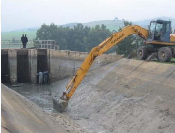
Figure 20 : Curage d'un canal par les moyens mécaniques (Cliché. OPIM, 2008)
