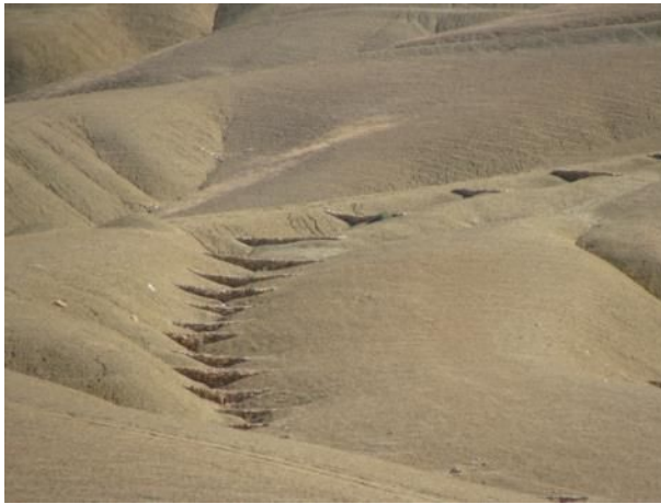
Figure 22 : Une série de seuils réalisée sur une ravine du bassin versant de Beni Chougarne (cliché. Remini, 2014)
