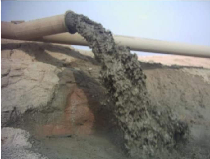
Figure 30 : Rejet de la vase lors de l'opération de dragage de 2005-2006 (cliché Remini, Mai 2006)
