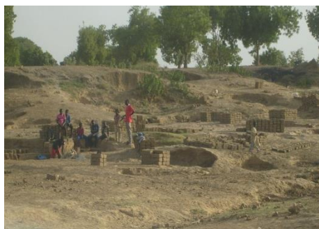
a) Fabrication des blocs de terre sur les berges du Logone à Kousseri
