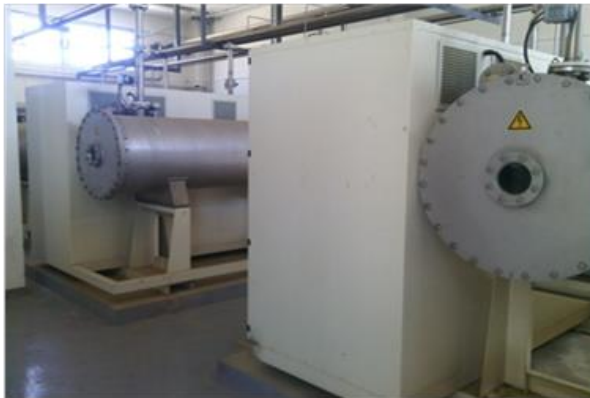
Figure 3 : Générateur d'ozone utilisé dans la station d'Aïn Tinn
