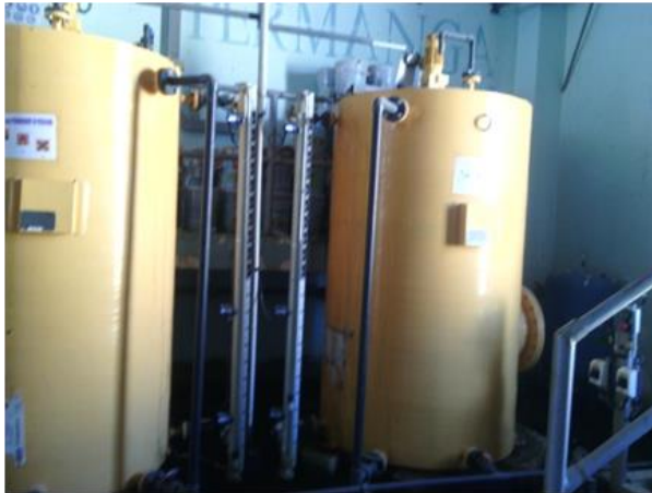
Figure 2 : Système de préparation du permanganate de potassium dans la station d'Aïn Tinn
