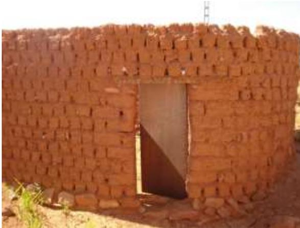
**Figure 10 : Mur de protection de la Kasria Lakbira d'une foggara de Timimoun (Remini, 2008)**
