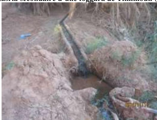
**Figure 24 : Kasria tertiaire de la foggara de Meghaier dans l'oasis de Timimoun (Remini, 2015)**
