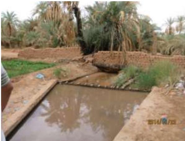
**Figure 20 : Grande Kasria d'une foggara d'Augrout (Remini, 2014)**
