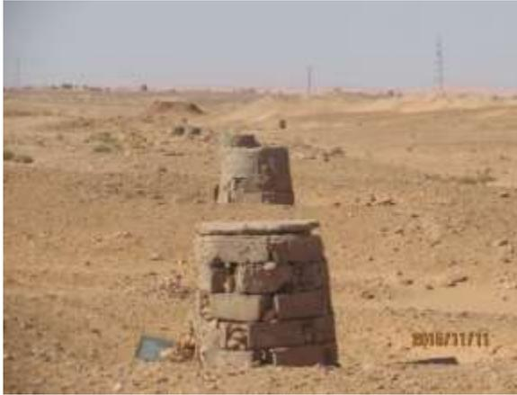
**Figure 14 : Alignement d'une série de puits d'aération d'une foggara de Reggane (Remini, 2015)**
