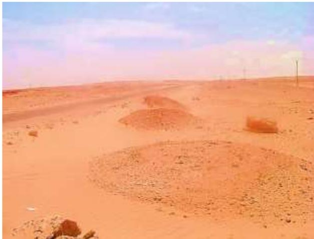
**Figure 15 : Une série de puits non aménagés d'une foggara de Timimoun (Remini, 2008)**
