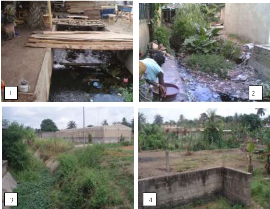
Figure 9 : Occupation des ouvrages (1), obstruction des voies d'évacuation des eaux pluviales (2 et 3) et construction des habitations dans les bas-fonds (4)
