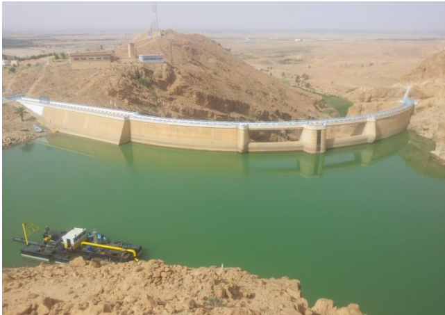
Figure 21 : La drague dans la retenue de Foug El Gherza (photo. Mazouz, 2015)
