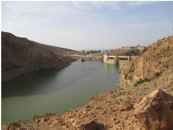
Figure 2 : Vue générale du barrage de Foug El Gherza (photo. Remini, 2016)
