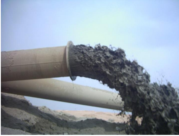
Figure 19 : Rejet de la vase lors de l'opération de dragage de 2005-2006 (Photo. Remini, 2006)
