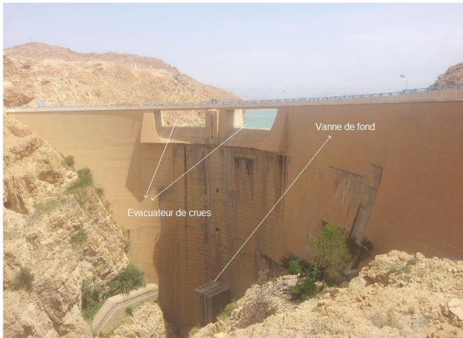
Figure 11 : Vanne de fond du barrage de Foug El Gherza (photo. Remini, 2016)
