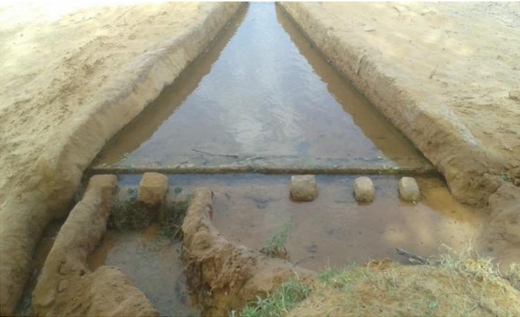
**Figure 22 : Kasria Lakkira de la foggara de Bouzegdad renforcée Par un forage (Kentaoui, Remini, 2016)**
