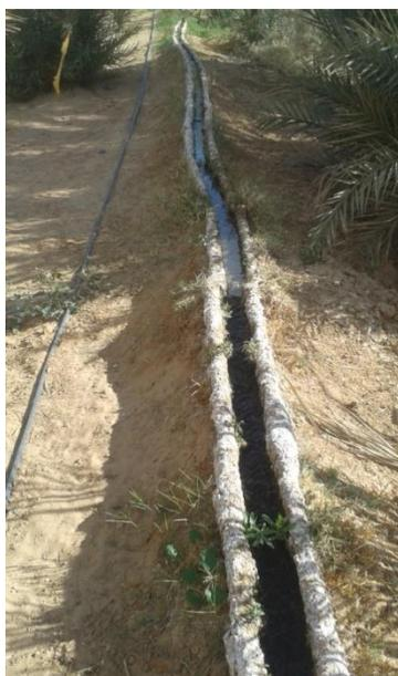
**Figure 8 : Seguia Tertiaire d'une foggara de Zaouiet Kounta (Kentaoui, 2016)**
