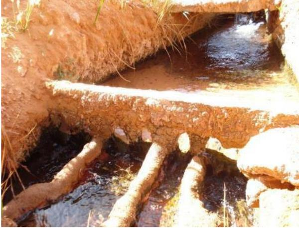
**Figure 27 :** Kasria d'une foggara de Timimoun un système de partage des eaux souterraines (Photo. Remini, 2008)
