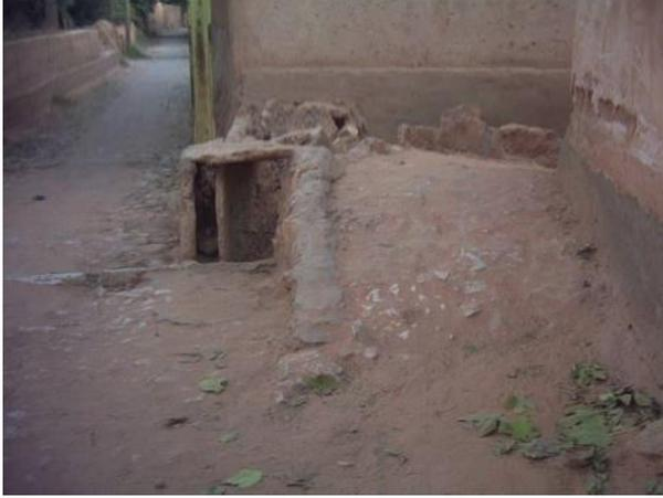
**Figure 22** : Un seuil de forme de dos d' ne pour emp cher l'eau de s' couler dans hors secteur (Photo. Remini, 2006)
