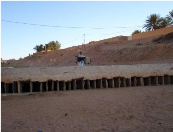
**Figure 28 :** Tissanbadh du système des foggaras de Ghardaïa : un système de partage des eaux superficielles (Photo. Remini, 2009)
