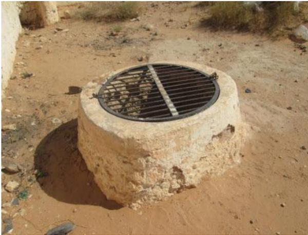
**Figure 14 :** Un puits d'aération et d'accès à l'intérieur de la galerie (Photo. Remini, 2010)
