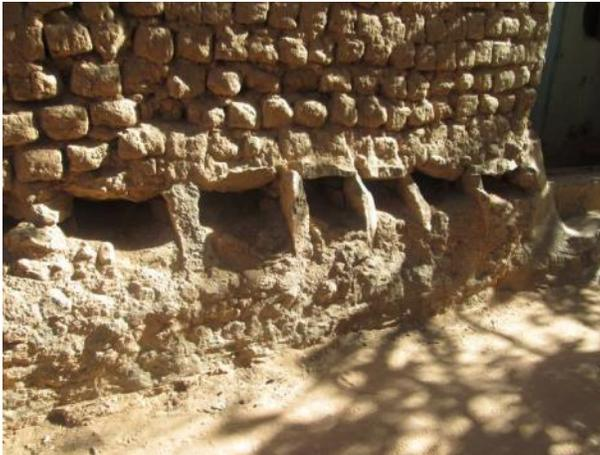
**Figure 23** : Un syst me d' vacuation des eaux de crues de 6 ouvertures d'un jardin de la palmeraie de Ghardaïa (Photo. Remini, 2013)
