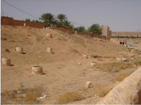
**Figure 13 :** Une vue sur les puits d'aération des foggaras de Ghardaïa (photo. Remini, 2010)
