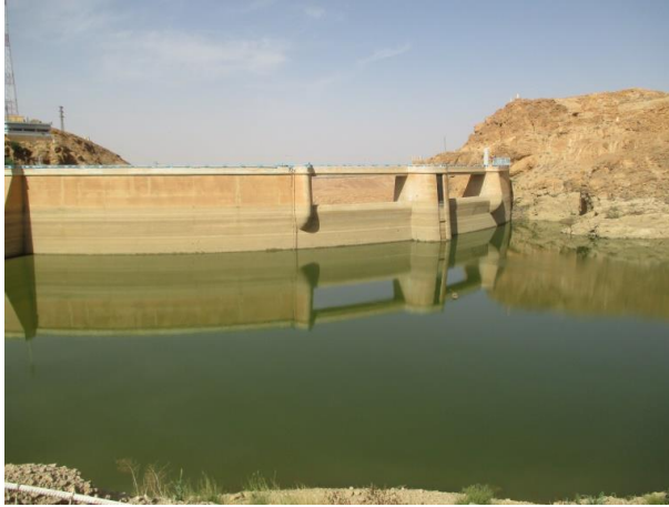
Figure 2 : La voute du barrage de Fom El Gherza (Photo. Remini, 2017)
