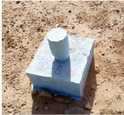
Figure 13 : Piézomètre fonctionnel de la rive gauche RG 8N (photo. REMINI Mai 2017)
