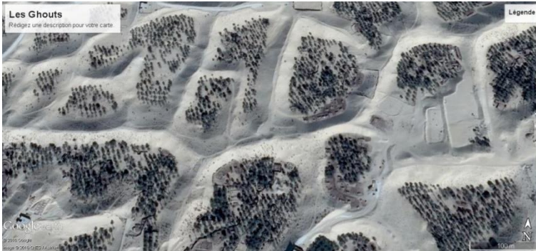
Figure 8 : Vue aérienne des Ghouts dans la région du Souf (Google Earth)
