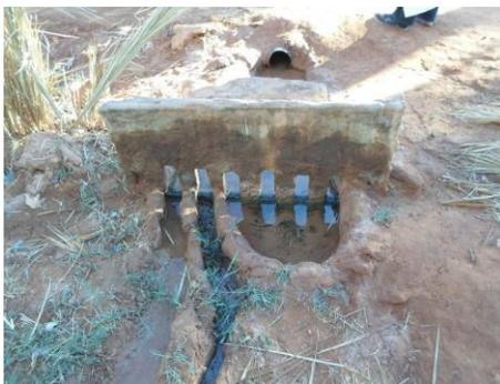
Figure 8 : Kasria Tertiaire de la foggara d'Irsan
