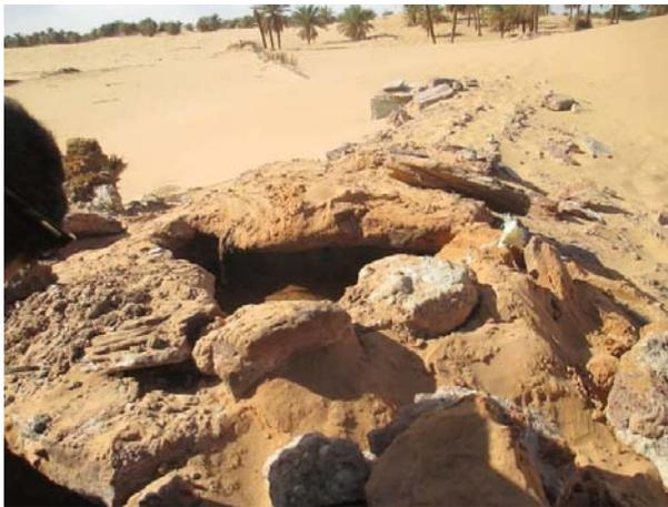
**Figure 3 : Segua couverte par des roches plates, un moyen de lutte contre l'ensablement**
