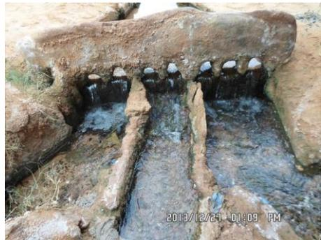
**Figure 11 : Kasria de forme triangulaire**      **Figure 12 : Machte d'une kasria**
