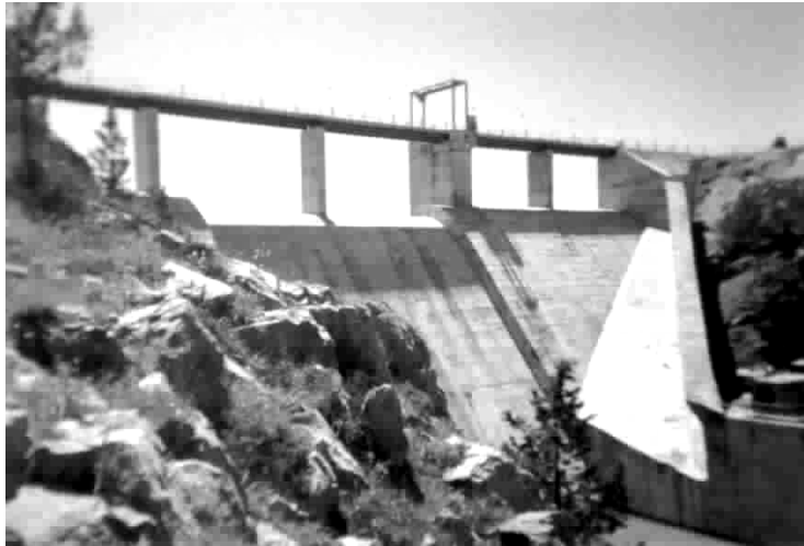
Photographie 1 : Vue générale de la digue du barrage de Hammam-Grouz
