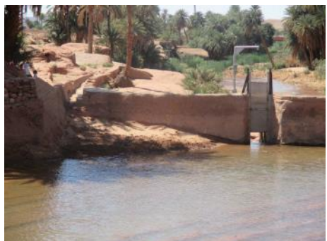
Figure 49 : Nouvelle porte coulissante du barrage Foukani (Photo. Remini, 2017)
