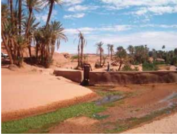
Figure 40 : La position de la porte coulissante en face du dépôt sableux (Photo. Remini, 2006)
