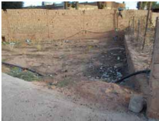
Figure 34 : Madjen 2 qui reçoit le surplus de l'eau en provenance du barrage Foukani via la seguia Cherkia (photo. Remini, 2014)
