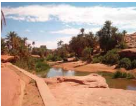
Figure 52 : Une partie de la seguia Foukania Charkia colmatée par la boue (photo. Remini, 2009)
