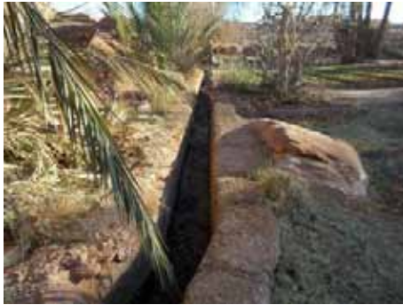
Figure 32 : Seguia Gharbia réalisée avec le mortier de la chaux et les granulats (photo. Remini,2014)
