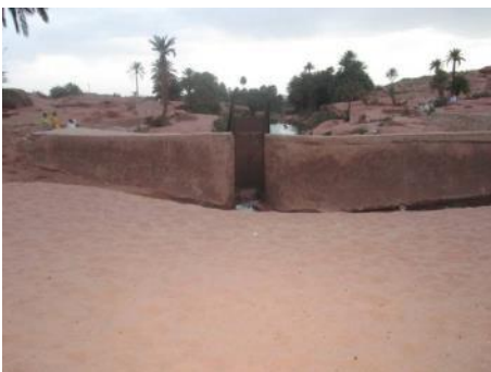
Figure 48 : Ancienne porte coulissante du barrage Foukani (Photo. Remini, 2013)
