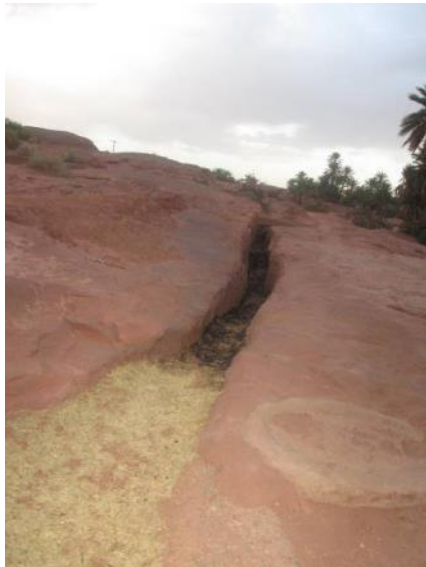
Figure 31 : Une partie du seguia Charkia sculptée au milieu d'un sol rocheux (photo. Remini, 2006)
