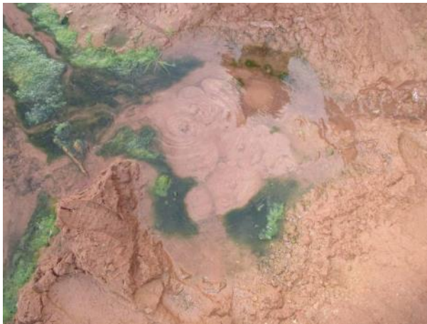
Figure 17 : Une source d'eau sur le lit du barrage Foukani (Photo. Remini, 2018)
