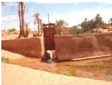
Figure 30 : Vanne coulissante du barrage Foukani (Photo. Remini, 2008)
