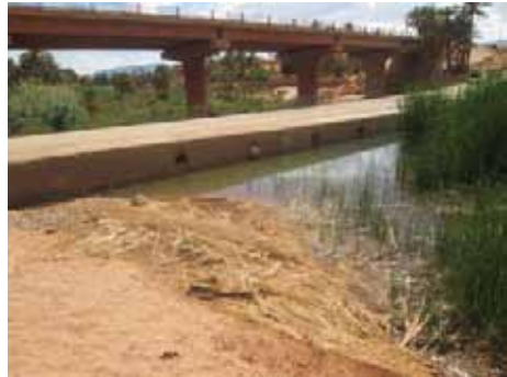
Figure 21 : La partie amont du barrage Tahtani (photo. Remini, 2018)
