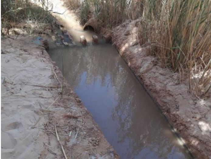
Figure 10 : L'eau s'écoule de nouveau dans la kasria de la foggara Hadj Amar Lekbir (Auteurs, 2018)
