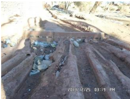
Figure 30 : Kasria de la foggara de Taurfine abandonnée (Photo. Auteurs, 2013)
