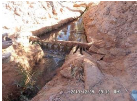
Figure 13 : Kasria secondaire de la foggara de Tifena (Aoulef Arab) (photo. Auteurs 2013)
