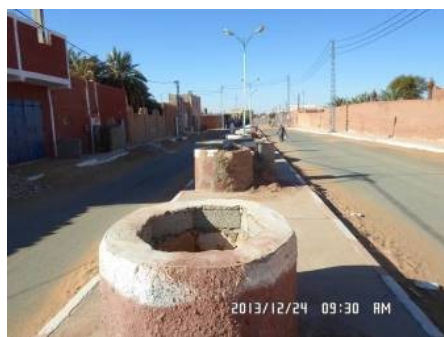
Figure 6 : Série de puits : synonyme de l'existence d'une galerie sous le sol (photo. Auteurs 2013)
