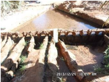
Figure 12 : Kasria principale de la foggara Djenet Esghar (Aoulef Arab) (photo. Auteurs 2013)
