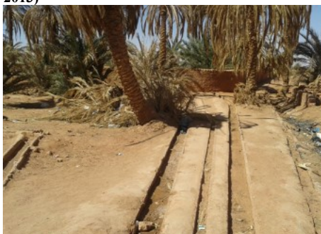
Figure 32 : Seguias de la foggara de Taurfine abandonnées (Photo. Auteurs, 2013)
