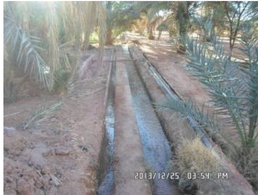
Figure 15 : Seguias de différentes sections dans le réseau de distribution de la foggara Fguiguira d'Aoulef Arab (photo. Auteurs 2013)
