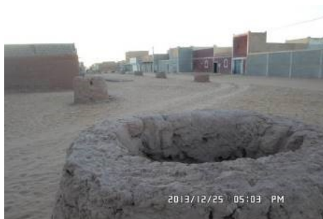
Figure 10 : Puits réhabilité en terre d'une foggara de l'oasis d'Aoulef Arab (photo. Auteurs 2013)
