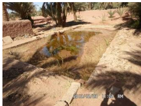
Figure 17 : Un des madjens en ciment de la foggara de Bendraou (Aoulef Arab) (Photo. Auteurs 2013)
