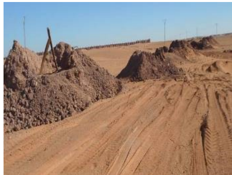
Figure 8 : Puits dans la partie drainage de la foggara de Tenfaa (Aoulef Arab) (Photo. Auteurs 2013)
