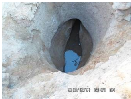
Figure 9 : Un puits situé dans la partie transport (faible profondeur) de la foggara de Tifena (Aoulef Arab) (Photo. Auteurs 2013)
