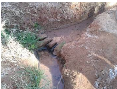
Figure 14 : Kasria tertiaire du réseau de distribution de la foggara Djenet Esghar (Aoulef Arab) (photo. Auteurs 2013)
