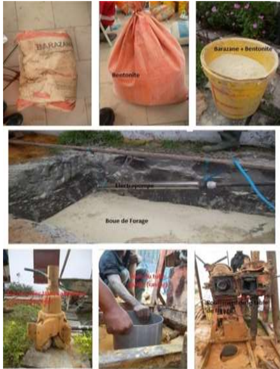
Figure 6 : Préparation de la boue de forage et la pose du tube guide de l'avant trou (Kashala, 2018).
