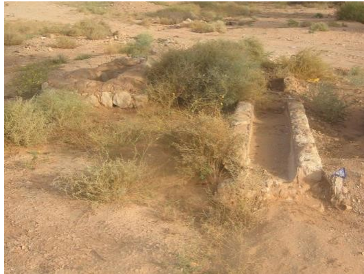
Figure 12 : Foggara de Tindouf ; Seguia dégradée (Photo. Auteurs, 2013)
