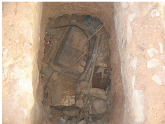
Figure 13 : Puits dégradé (Photo. Auteurs, 2013)
