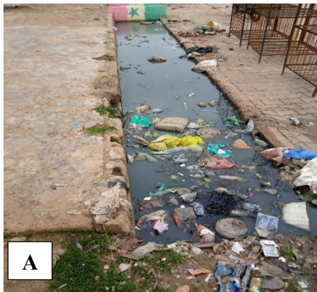
Photo 1 : Ouvrage de drainage mal dimensionné à Belfort (A) et conséquence après un événement pluvieux (B)
