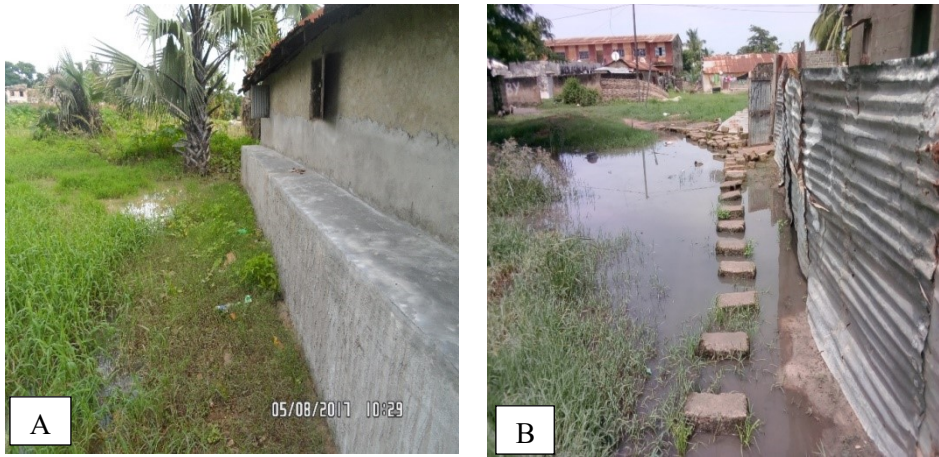
Photo 4 : Mur édifié pour empêcher la percolation des eaux de ruissellements (A), graviers remblais pour faciliter le passage (B).
