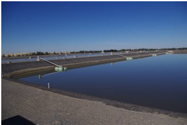
Figure 30 : Station d'épuration par lagunage qui a permis de donner une seconde vie pour le système traditionnel hydroagricole (ghout) (photo. Remini, 2018)
