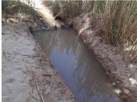
Figure 27 : La foggara Hadj Amar Lekbir : L'eau retrouve le chemin des seguias et les kasriates (Boutadara et Remini, 2018)
