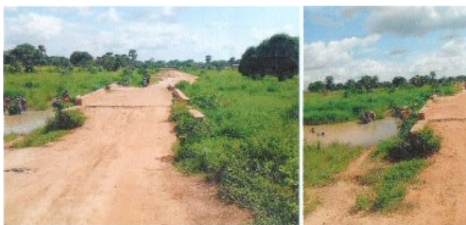
Figure 1 : Aspect de la digue piste à retenue au niveau de la rivière Lapié en saison pluvieuse (Source : HOUNTONDI, Babilas)
