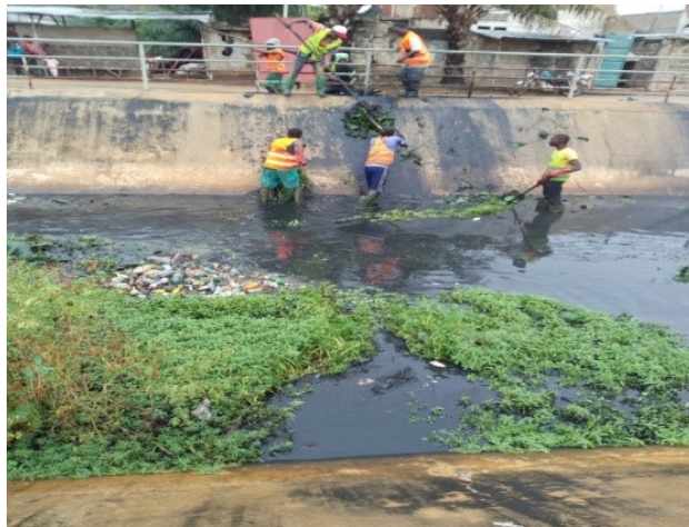
Figure 6 : Curage des caniveaux (Source : DAHOUNTO Hospice)
