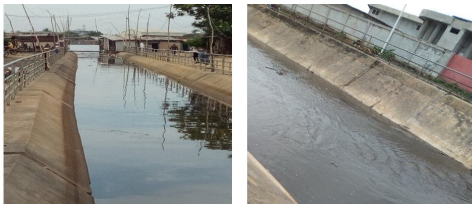
Figure 7 : Ecoulement des eaux usées et pluviales vers l'exutoire après curage des collecteurs (source: DAHOUNTO Hospice)
