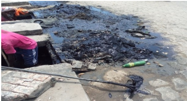
Figure 5 : Curage de collecteur (Source : DAHOUNTO Hospice)
