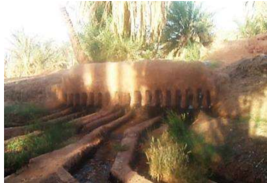
Figure 9 : Kasria secondaire de la foggara de Meghier de l'oasis de Timimoun (Photo. Remini, 2007)
