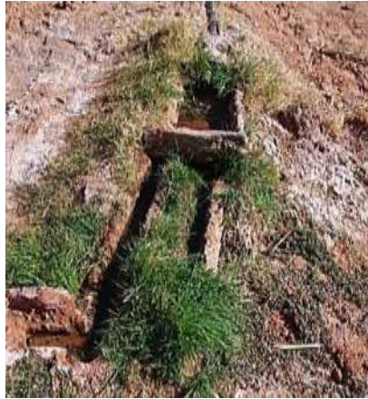
Figure 13 : Kasria Multiple d'une foggara de l'oasis de Timimoun (Remini, 2019)
