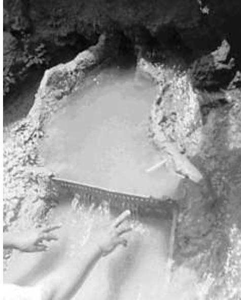
Figure 27 : Opération de jaugeage de la foggara d'une oasis de Timimoun (photo. Remini, 2007)
