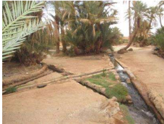
Figure 22 : Réseau de seguias de la foggara de Boukais (Photo. Remini, 2013)
