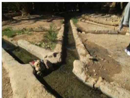
Figure 35 : Seguias de mêmes dimensions dans le réseau de la foggara de Boukais (Remini, 2014)
