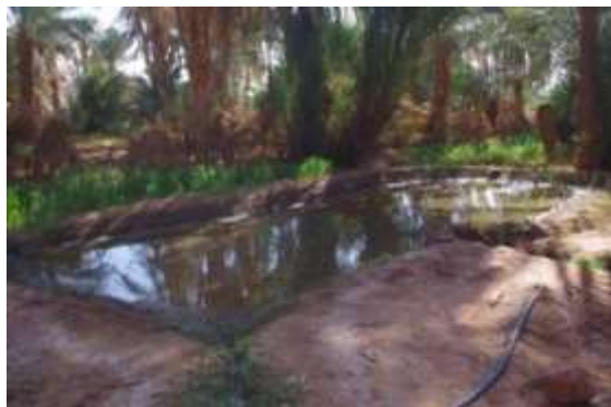
Figure 15 : Madjen individuel de forme rectangulaire de la Foggara de l'oasis de Feraoun (Photo. Remini, 2019)
