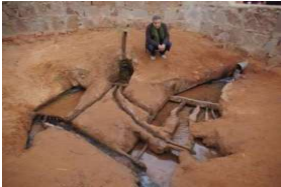
Figure 14 : Kasrias de la triple foggara de l'oasis d'Ouled Said (Photo. Remini, 2019)
