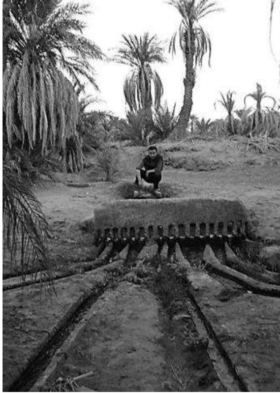
Figure 44 : Kasria (Yahia) de la foggara d'El Meghier ; un lieu jaugeage du débit d'eau (Photo. Remini, 2008)
