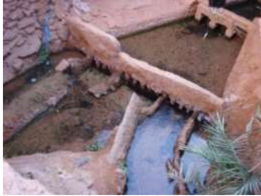
Figure 8 : Kasria principale de la foggara Meghier de l'oasis de Timimoun (Photo. Remini, 2008)
