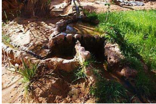
Figure 11 : Kasia secondaire de la Faggora de l'oasis de Guentour (Timimoun) (Photo. Remini, 2019)
