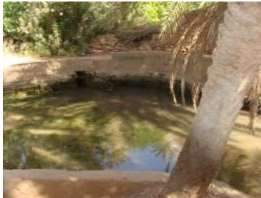
Figure 21 : Madjen collectif de la foggara de Moghrar (Remini et Achour, 2017)
