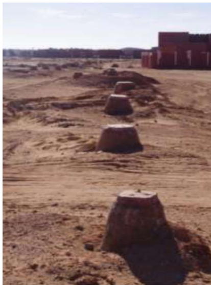
Figure 2 : Alignement des puits d'aération d'une foggara de l'oasis de Tinerkouk (Remini, 2019)
