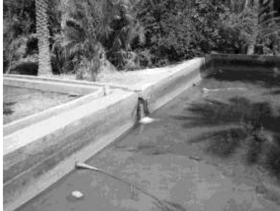
Figure 45 : Madjen collectif de la foggara El Foukania de Moghrar Un lieu de quantification des parts d'eau en utilisant la methode du bâton gradué (Photo. Remini, 2011)
