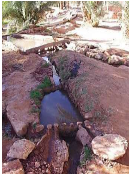
Figure 12 : Foggaras principale et secondaire de la foggara de l'oasis de Guentour (Remini, 2019)
