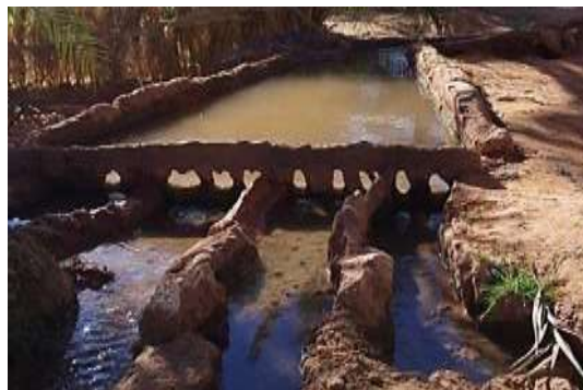
Figure 10 : Kasria principale de la foggara de l'oasis de Guentour (Timimoun) (Photo. Remini, 2019)
