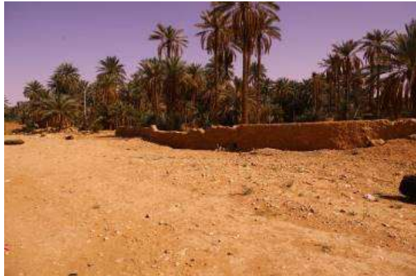
Figure 10 : Une vue de la digue du grand barrage Si Lekhel (Photo. Remini, 2019)
