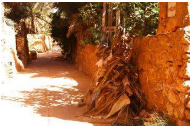
Figure 4 : Les dépôts des déchets de palmes d'une hauteur de 1,2 m montre un peu la hauteur de la dernière crue (Crue de 20/04/2018) (Photo. Remini, 2019)
