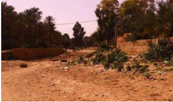
Figure 51 : Une vue de la galerie d'évacuation des eaux pluviales vers l'oued Metlili (Photo. Remini, 2019)
