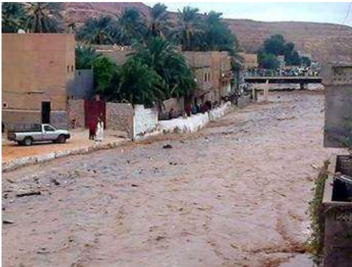
Figure 2 : L'oued Metlili en crue (Crue 01 /10/2008 Debit max = 850 \text{ m}^3/\text{s} (Photo. Ouled Belkhir, 2008)
