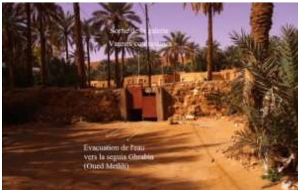
Figure 53 : La sortie de la galerie d'évacuation des eaux pluviales Par de portes coulissantes (Photo. Remini, 2019)
