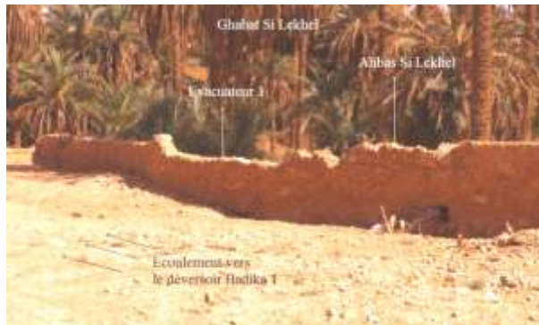
Figure 48 : Déversoir 3 pour déverser l'eau dans les jardins de Ghaba El Haddour (Photo. Remini, 2019)
