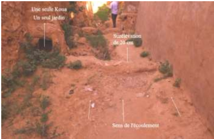
Figure 26 : Une seule koua (alimentant un seul jardin) située dans une seguia très dégradée et non entretenue (Photo. Remini, 2019)
