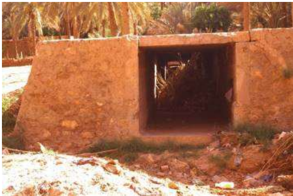
Figure 52 : L'entrée de la galerie d'évacuation des eaux pluviales (Photo. Remini, 2019)
