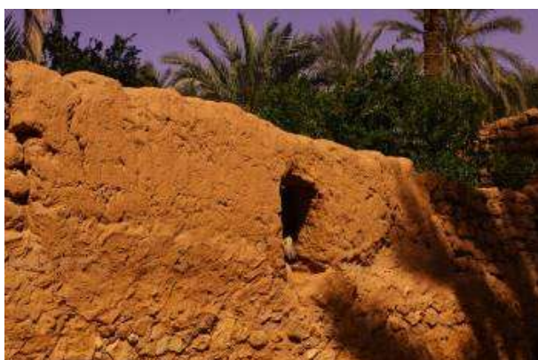
Figure 36 : Dispositif d'évacuation à 1 ouverture du surplus d'eau vers l'oued Metlili (Photo. Remini, 2019)
