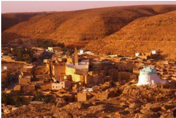
Figure 6 : Une vue générale du ksar de Metlili (Photo. Remini, 2019)
