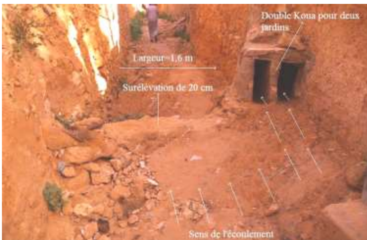
Figure 25 : Double koua (alimentant deux jardins consécutifs) située dans une seguia secondaire très dégradée et non entretenue (Photo. Remini, 2019)
