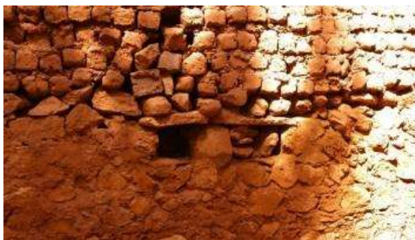
Figure 35 : Dispositif d'évacuation à 2 ouvertures du surplus d'eau vers l'oued Metlili (Photo. Remini, 2019)
