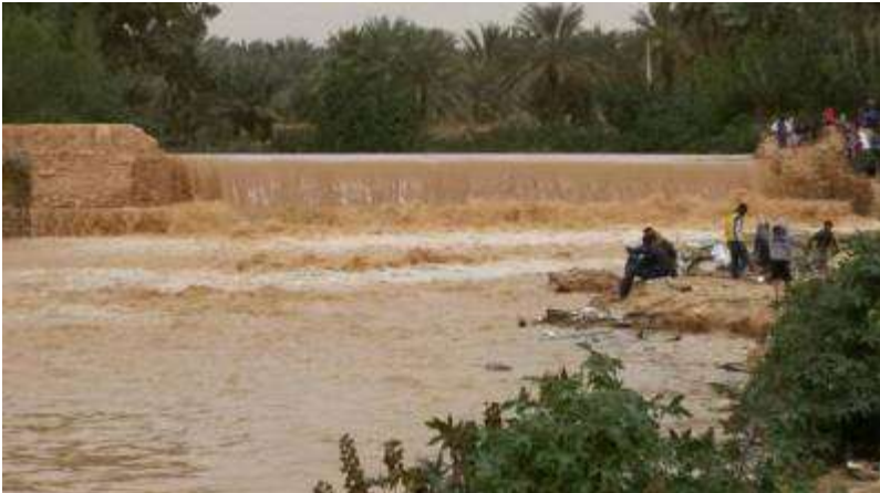
Figure 20 : Ahbas El Arch sur l'oued Metlili (Crue de 20/04/2018) (Photo. Ouled Cheikh, 2018)
