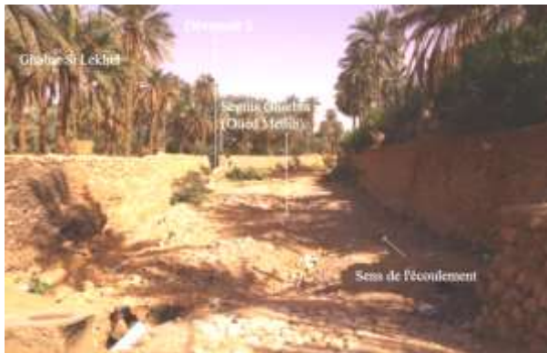
Figure 50 : Déversoir 3 pour évacuer le surplus vers l'oued Metlili (Photo. Remini, 2019)
