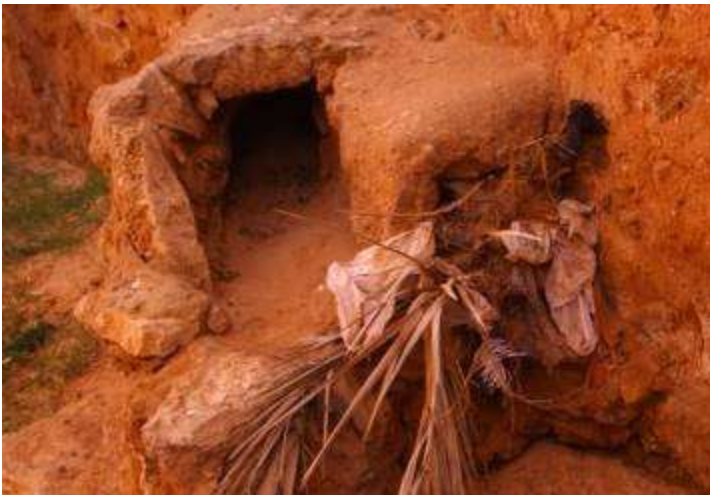
Figure 27 : Double koua bouchée par des débris lors de la dernière crue (Photo. Remini, 2019)
