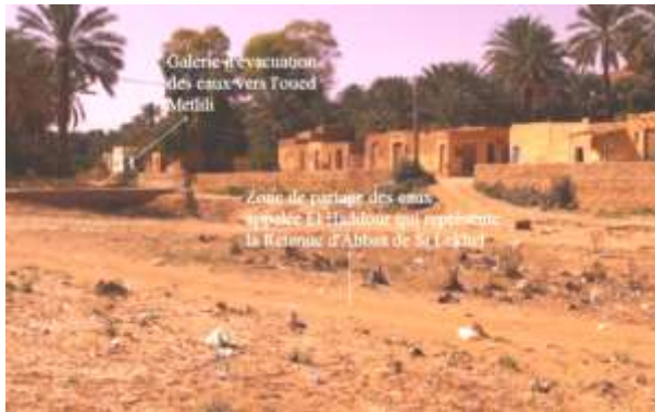
Figure 41 : Une vue de la zone El Haddour : le lieu du partage des eaux de crues (Photo. Remini, 2019)
