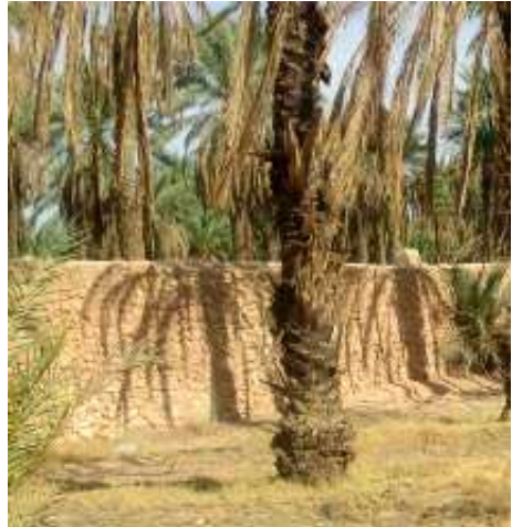
b) l'amont de la digue
