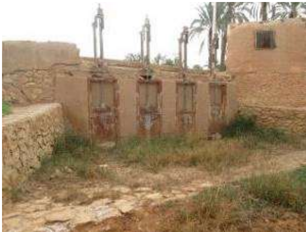
Figure 12 : Première batterie de vannes coulissantes (Remini, 2014)
