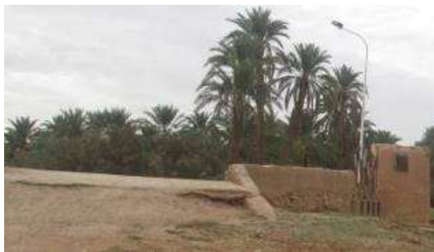
Figure 16 : Vue de l'évacuateur de crues du barrage d'El Guerrara (Photo. Remini, 2014)
