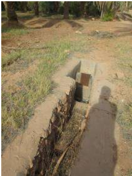
a) Réservoir équipé d'une porte coulissante
