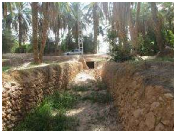
Figure 23 : Seguia reliant la sortie de la vanne à portes coulissantes (Photo. Remini, 2014)
