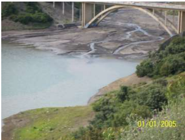
Figure 18 : Le barrage d'Ighil Emda, s'envase par courants de densité (Photo. Ouaret et Remini, 2005)
