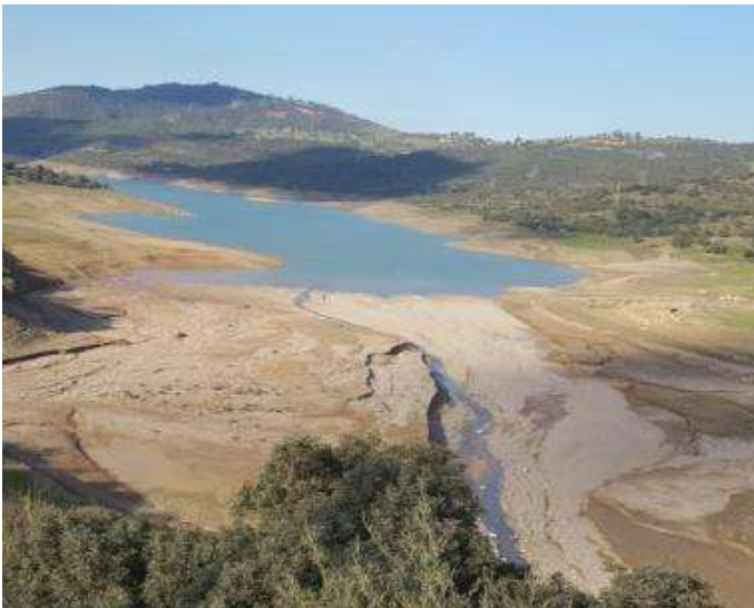
Figure 6 : Une vue de l'entrée du lac du barrage de Keddara (Photo. Remini, 2017)
