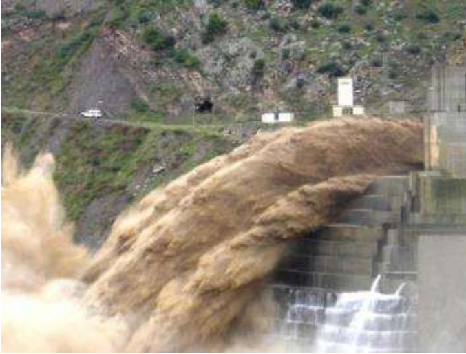
Figure 13 : Soutirage des courants de densité au barrage de Beni Haroun (Photo. ANBT)
