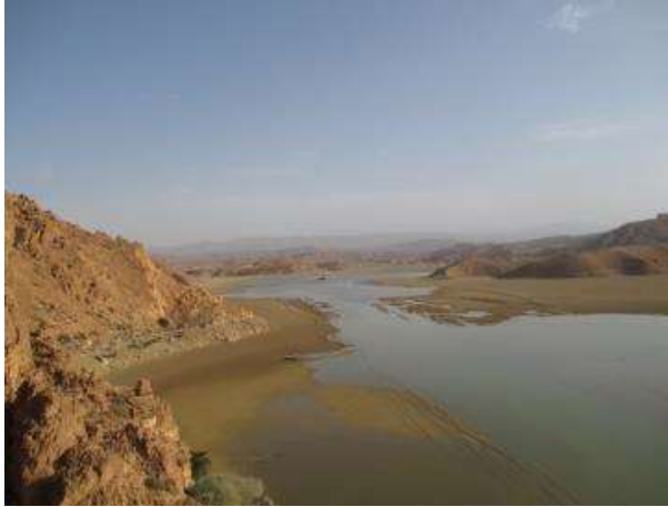
Figure 19 : Le barrage de Foum El Gherza s’envase par courants de densité (Photo. Remini, 2016)
