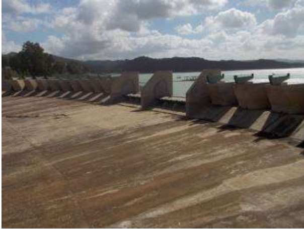
Figure 32 : Surélévation du déversoir du barrage de Ghib par les hausses fusibles (Photo. Remini, 2017)
