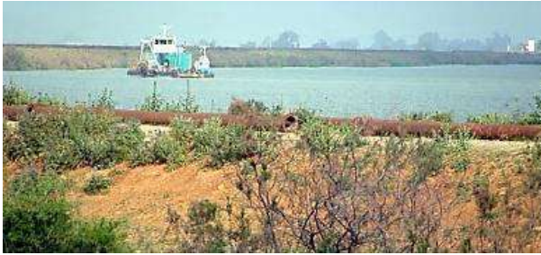
Figure 14 : Opération de dragage du barrage de Merdja (Photo. Remini, 2005)
