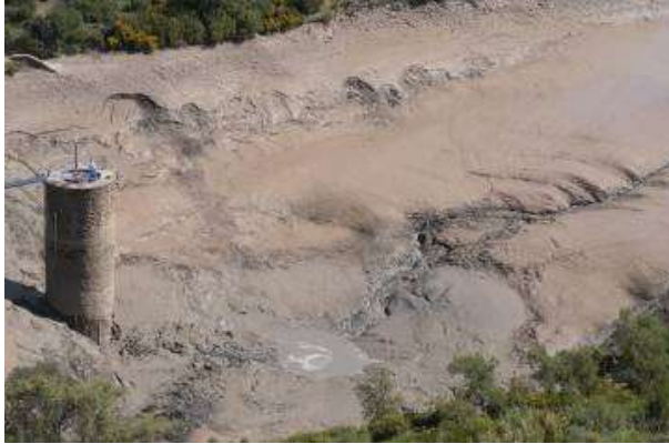
Figure 5 : Barrage Merurad : De la boue à la place de l'eau dans le lac (Photo. ANBT)
