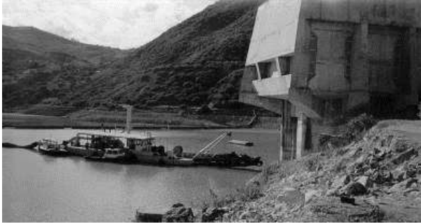
Figure 16 : Opération de dragage du barrage des Zardezas (Photo. Remini, 2006)
