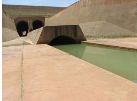
Figure 40 : Pertuis de vidange du barrage de Sidi Mhamed Ben Aouda (Photo. Remini, 2014)
