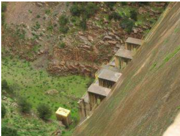
Figure 37 : Vannettes de soutirage des courants de densité du barrage d'Oued Fodda (Photo. Remini, 2008)
