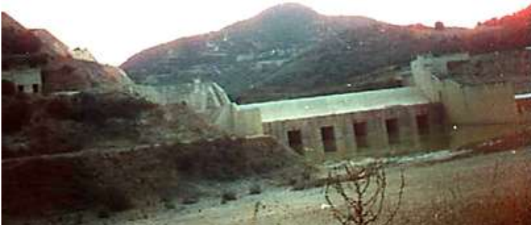
Figure 43 : Vannes d'évacuation de la boue par les chasses (Photo. Remini, 2006)
