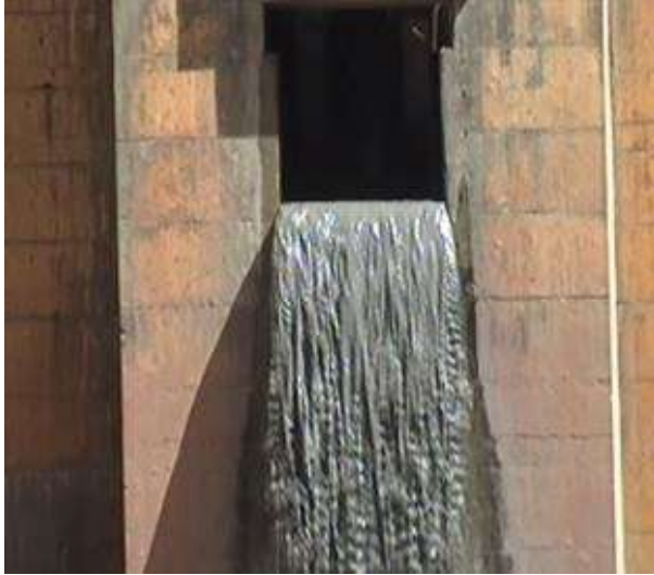
Figure 45 : Ouverture de la vanne de fond évacuer le boue qui est déposée auprès du pied du barrage (Photo. Remini, 2012)
