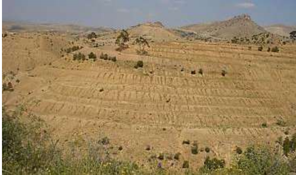
Figure 6 : Bassin versant d'oued Mina : Banquettes très dégradés accélèrent l'envasement du barrage de SMBA (Photo. Remini, 2014)
