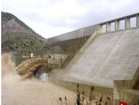
Figure 39 : La suspension soustrée par les pertuis de vidange du barrage de Beni Haroun indique bien qu'elle est récente émanant d'un courant de densité (Photo. ANBT)
