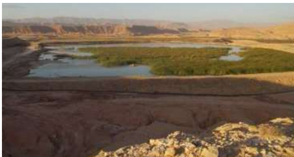
Figure 23 : Un des bassins de stockage de la boue refoulée par la drague lors de la deuxième opération de dragage (2015-2017) (Photo. Remini, 2018)
