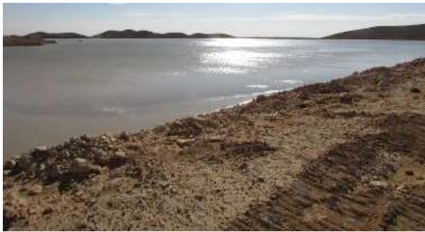
Figure 24 : Bassin de stockage de la boue refoulée à l'aval du barrage de Foum El Gherza en 2019. (Photo. Remini, 2019)
