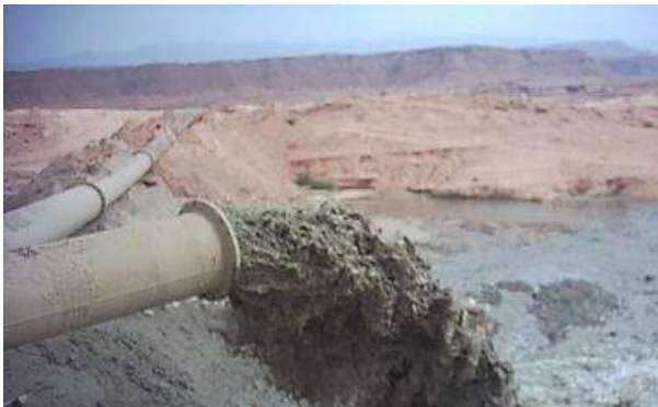
Figure 15 : Opération de dragage du barrage de Foum El Gherza (Photo. Remini, 2006)
