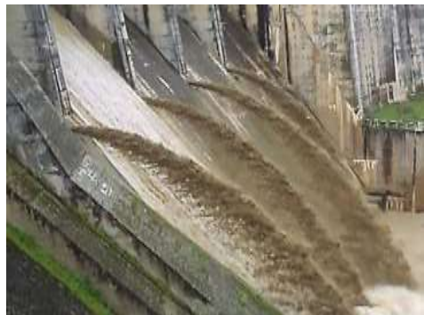
Figure 42 : Barrage Zardezas : Soutirage des courants de densité (Photo. ANBT)
