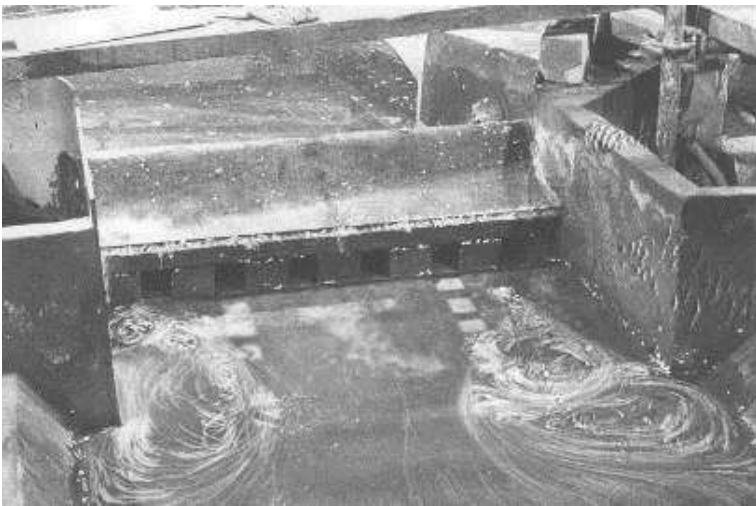
Figure 44 : Modèle réduit du barrage de Beni Amrane : Vannes d'évacuation de la boue par les chasses du barrage de Beni Amrane (Photo. Remini, 2006)
