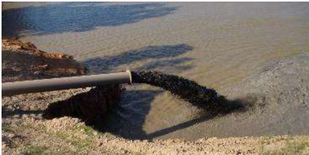
Figure 18 : Opération de dragage du barrage de Bouhanifia (Photo. Remini, 2015)
