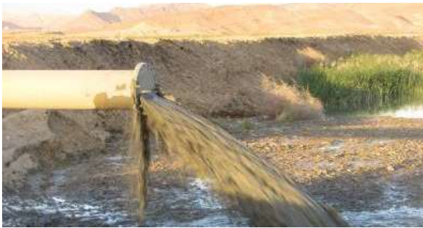
Figure 17 : Opération de dragage du barrage de Foum El Gherza (Photo. Remini, 2018)
