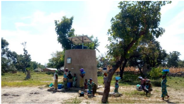
Figure 7 : Dispositif autonome d'approvisionnement mise en service et accessible (Prise de vue : AYELABOLA Mayeul, 2019)
