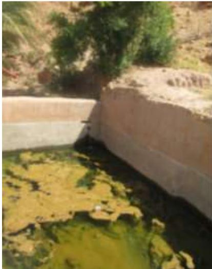
**Figure 5 : Madjen de la foggara de Sfisifa Stockage des eaux de la nappe alluviale (Photo. Remini, 2014)**
