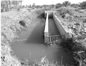
e) Entrée dans la conduite (P5)
