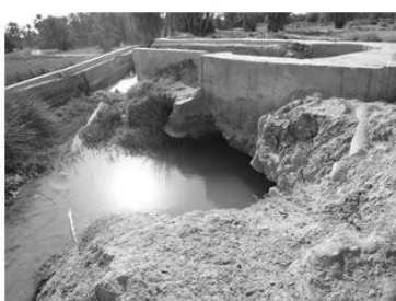
f) Sortée de la conduite (P6)
