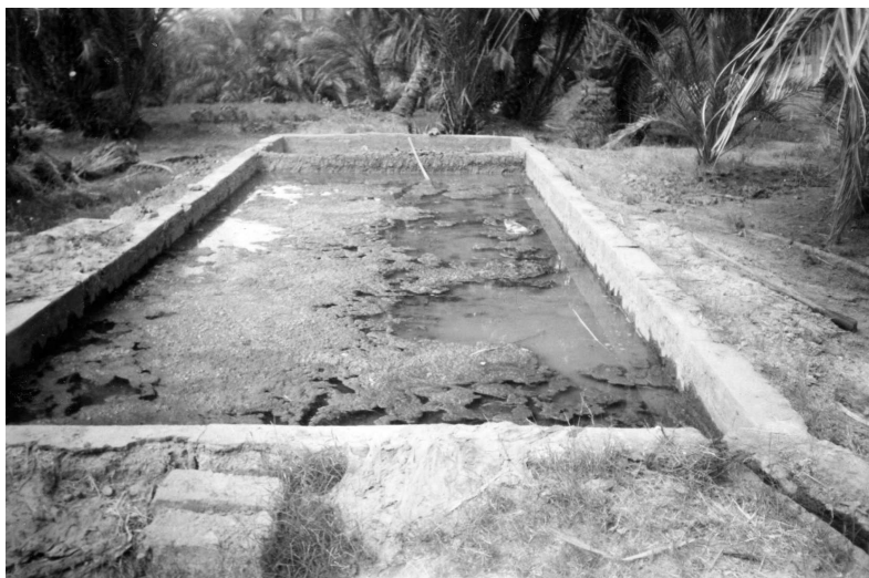
Photographie 4 : Madjen en ciment (Photo. Remini, 2000)
